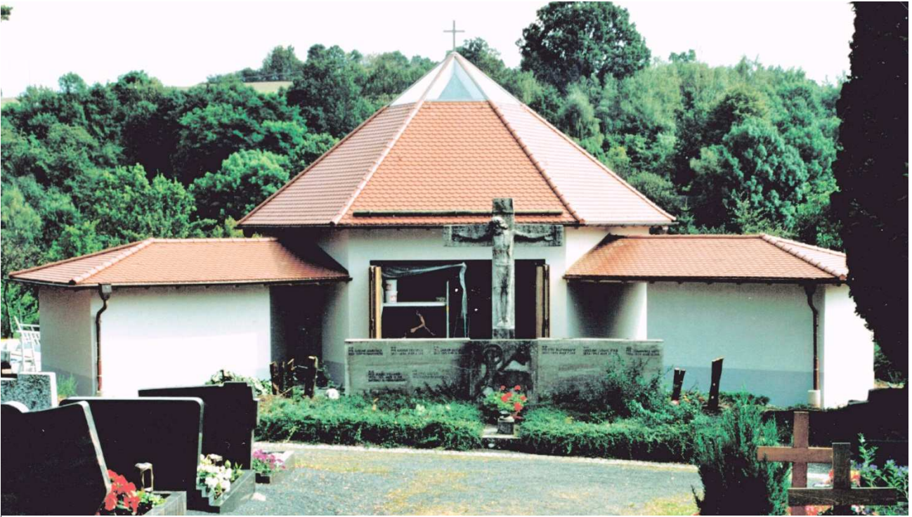
Bau der neuen Aussegnungshalle am Friedhof in Burkardroth. Entfernung des Priestergrabes im September 2002
