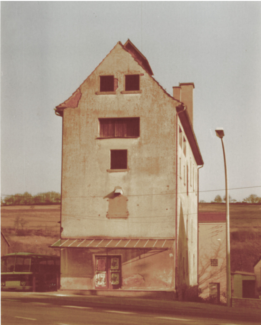
Die Gemeinschaftsbrauerei Zahlbach und Umgebung kurz vor dem Abbruch
