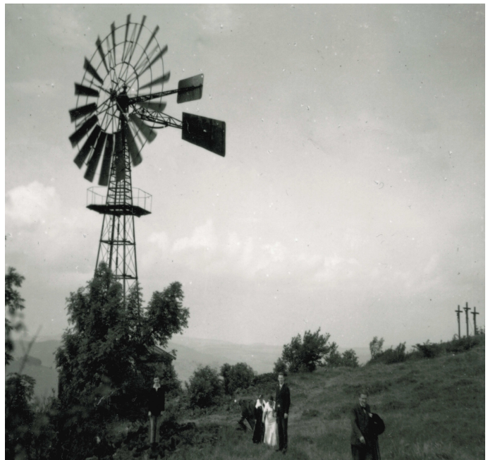
Windkraftanlage auf dem Kreuzberg, erbaut 1921 von Guardian Odorikus Röder. Die Anlage lieferte Gleichstrom für das Kloster und wurde 1948 verschrottet
